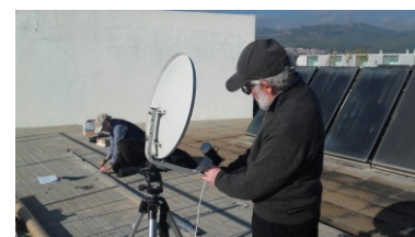
Preparando la instalación
